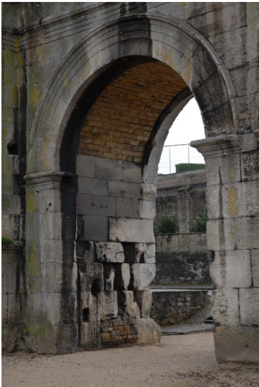
Baie centrale sud Paroi sud
