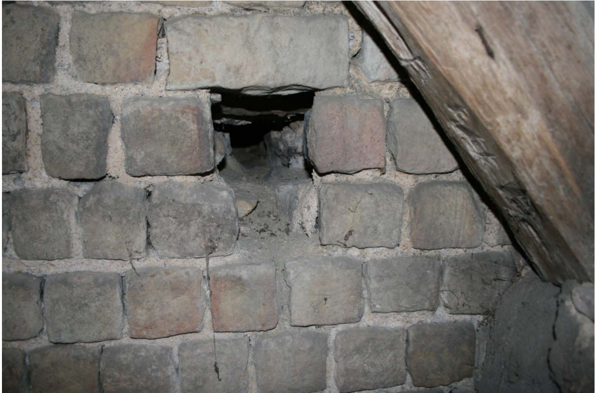
Parement extérieur sud .Trou de boulin (détail).
