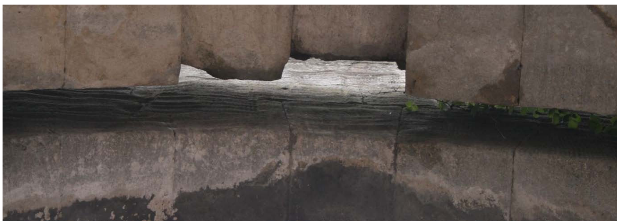
Manœuvre des herses : saignées verticales dans les voûtes centrales.
