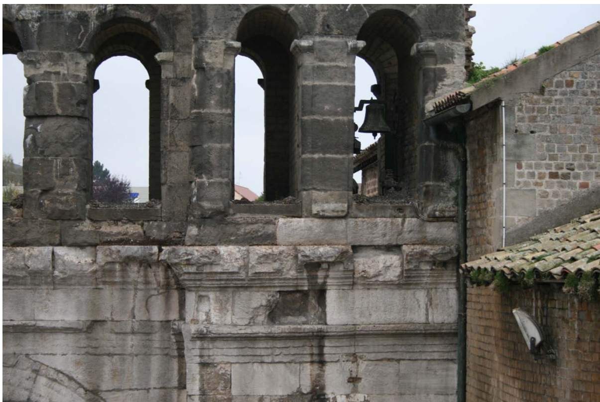
Façade, avant-corps nord. En haut : présence de deux blocs de calcaire oolithique appartenant structurellement au deuxième niveau de la porte (PSA-48). En bas : trace liée à l'aménagement d'un arc ogival dans une annexe de l'église voisine.
