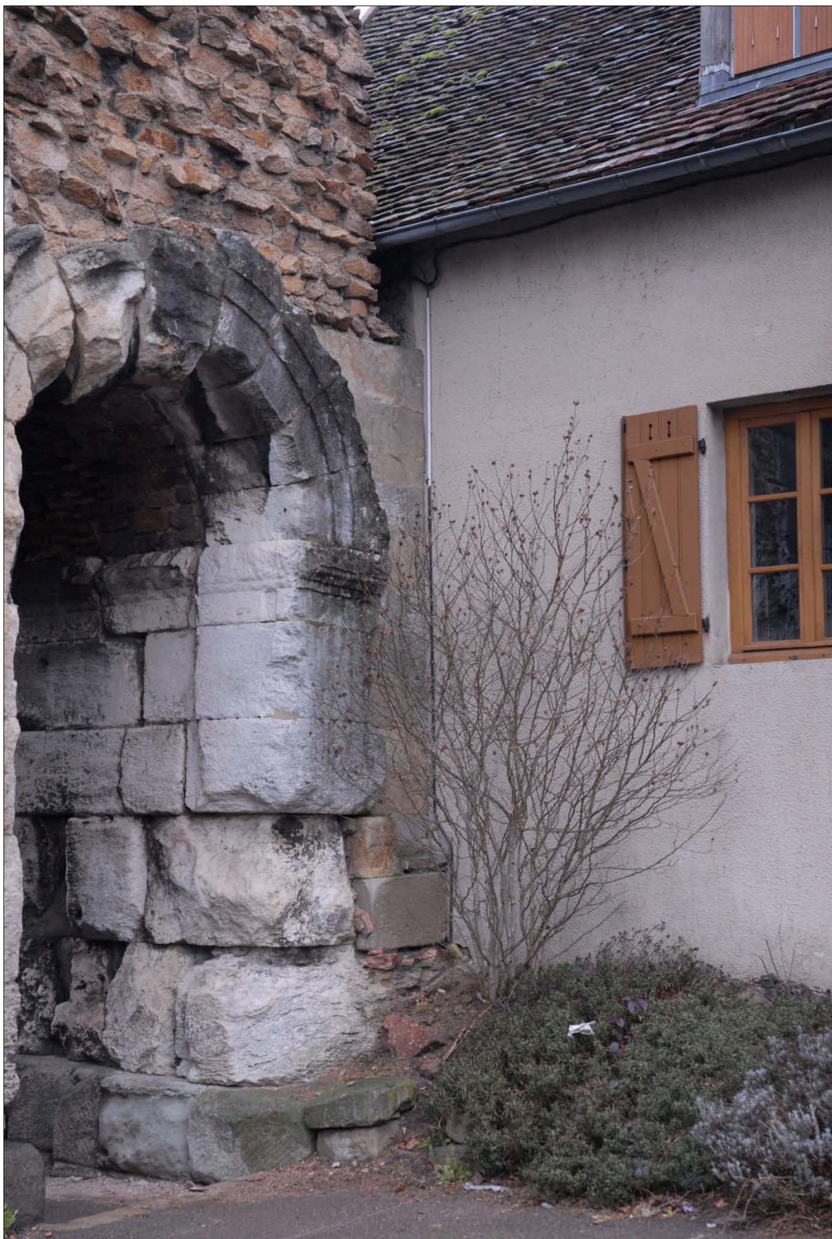
Vue de la baie latérale orientale (face arrière) : le contrefort PAX-37.
