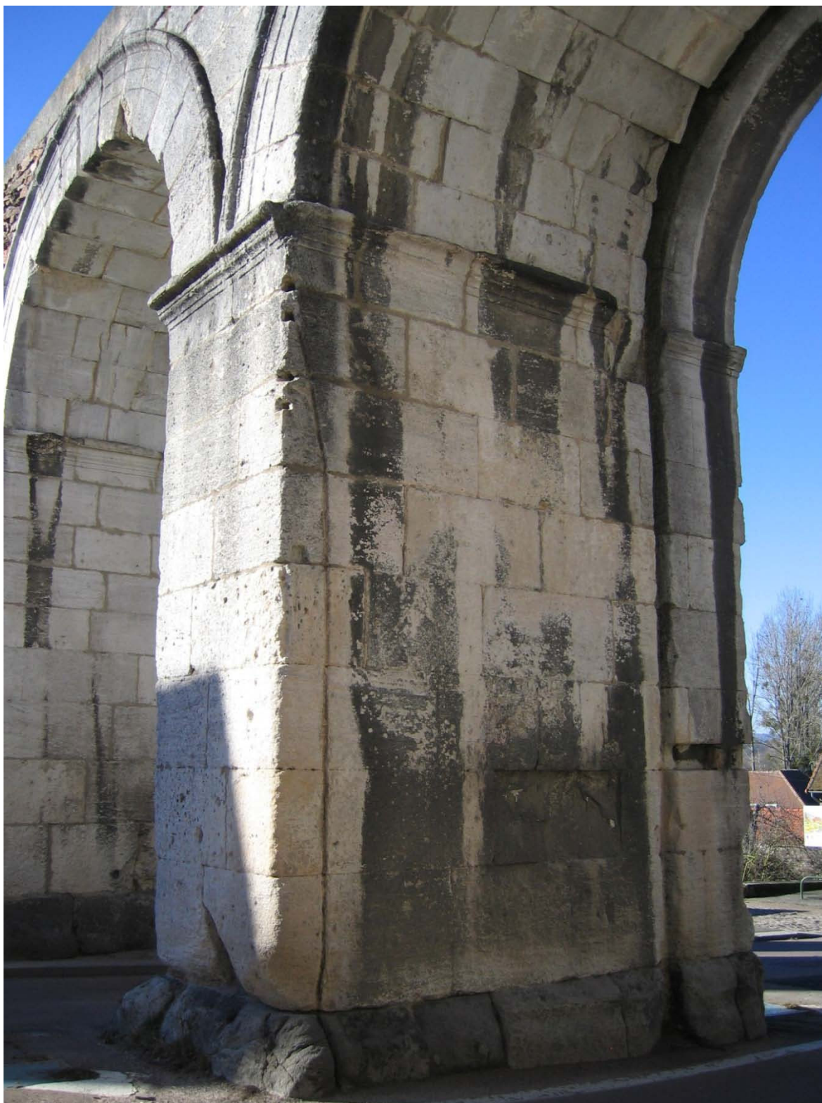
Paroi occidentale de la grande baie orientale, vue depuis l'intérieur de la ville. On note la saignée liée à l'installation d'un dispositif d'éclairage au gaz
