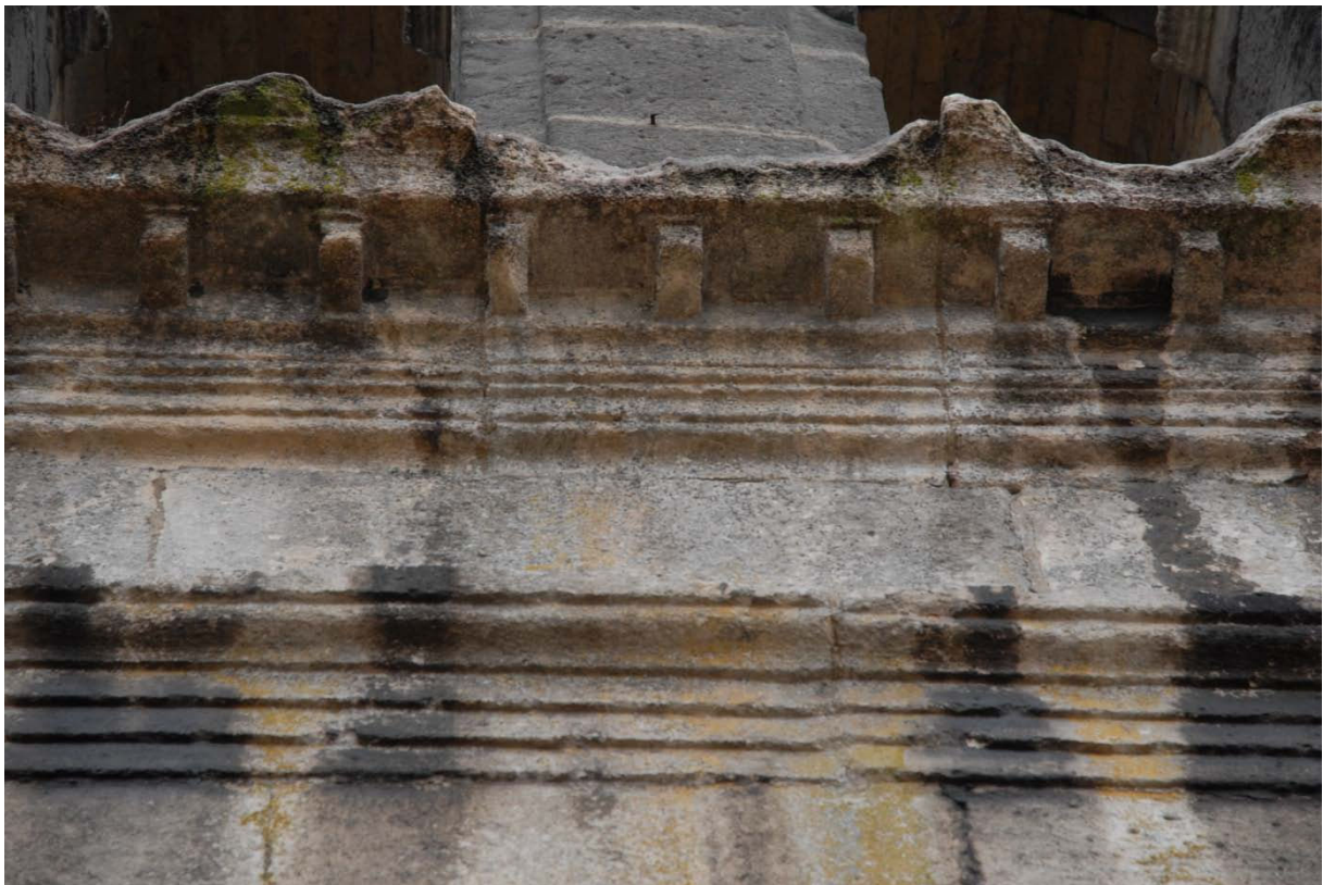
Façade, détail de la corniche intermédiaire.
