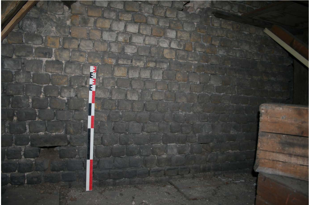
Parement extérieur sud (dans les combles de l'édifice moderne)
