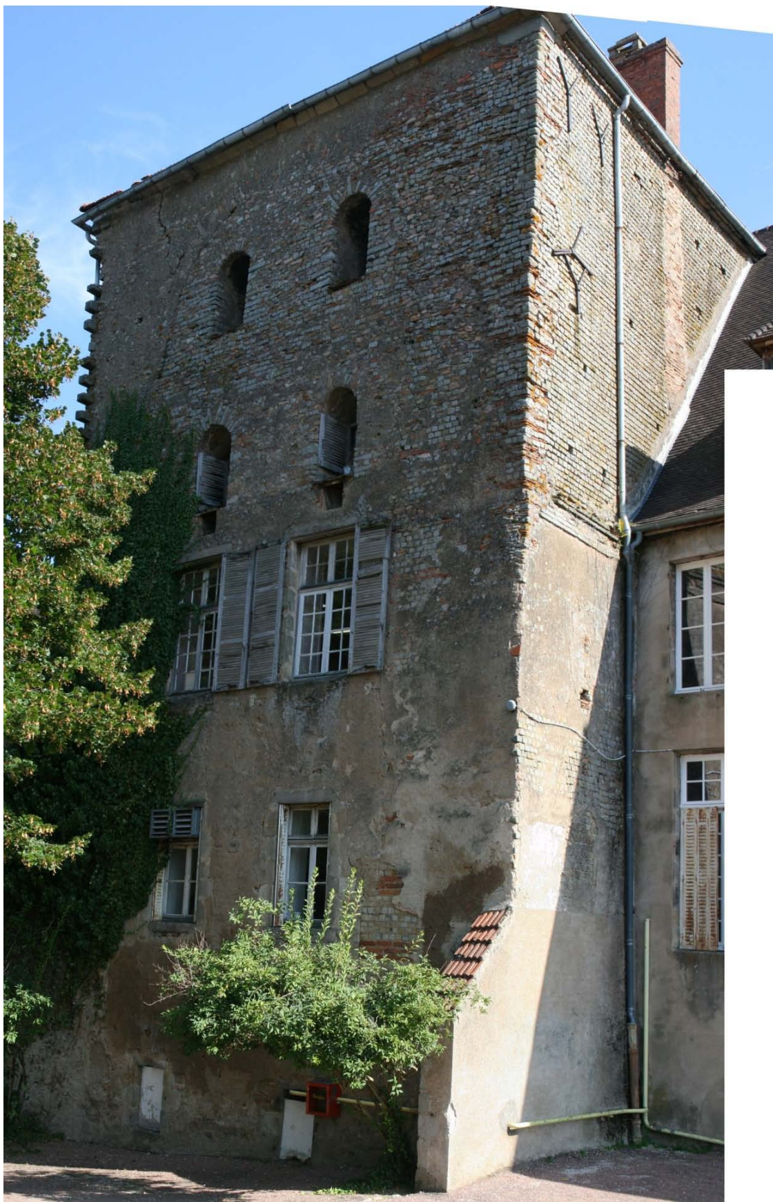
Paroi extérieure ouest, mur correspondant au diamètre de la partie antique semi-circulaire. A droite, paroi extérieure sud de la tour correspondant à l'ancien côté long de la tour romaine.
