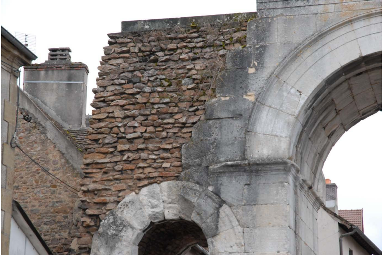
Partie orientale de la façade. Massif de blocage (1901-1904). On note que l'imposte gauche de la baie centrale orientale n'a pas été retaillée, contrairement à son pendant occidental.
