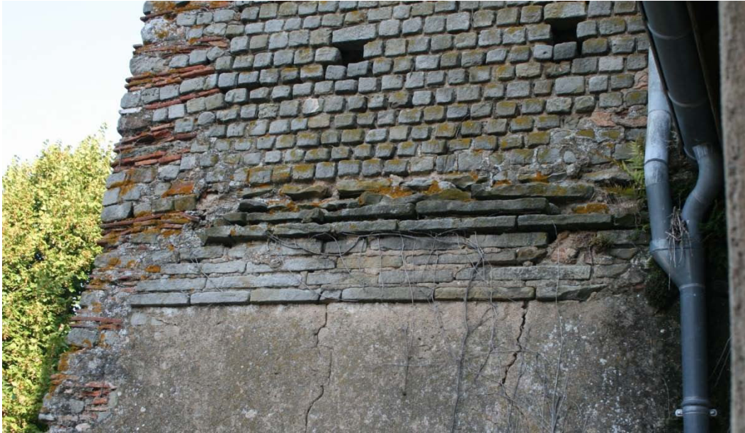
Paroi extérieure sud : pseudo-entablement intermédiaire. Enduit contemporain, en partie basse ; parement en petit appareil quadrangulaire, en partie haute (restauration contemporaine ?) ; chaînage d'angle avec assises de briques, à gauche.
