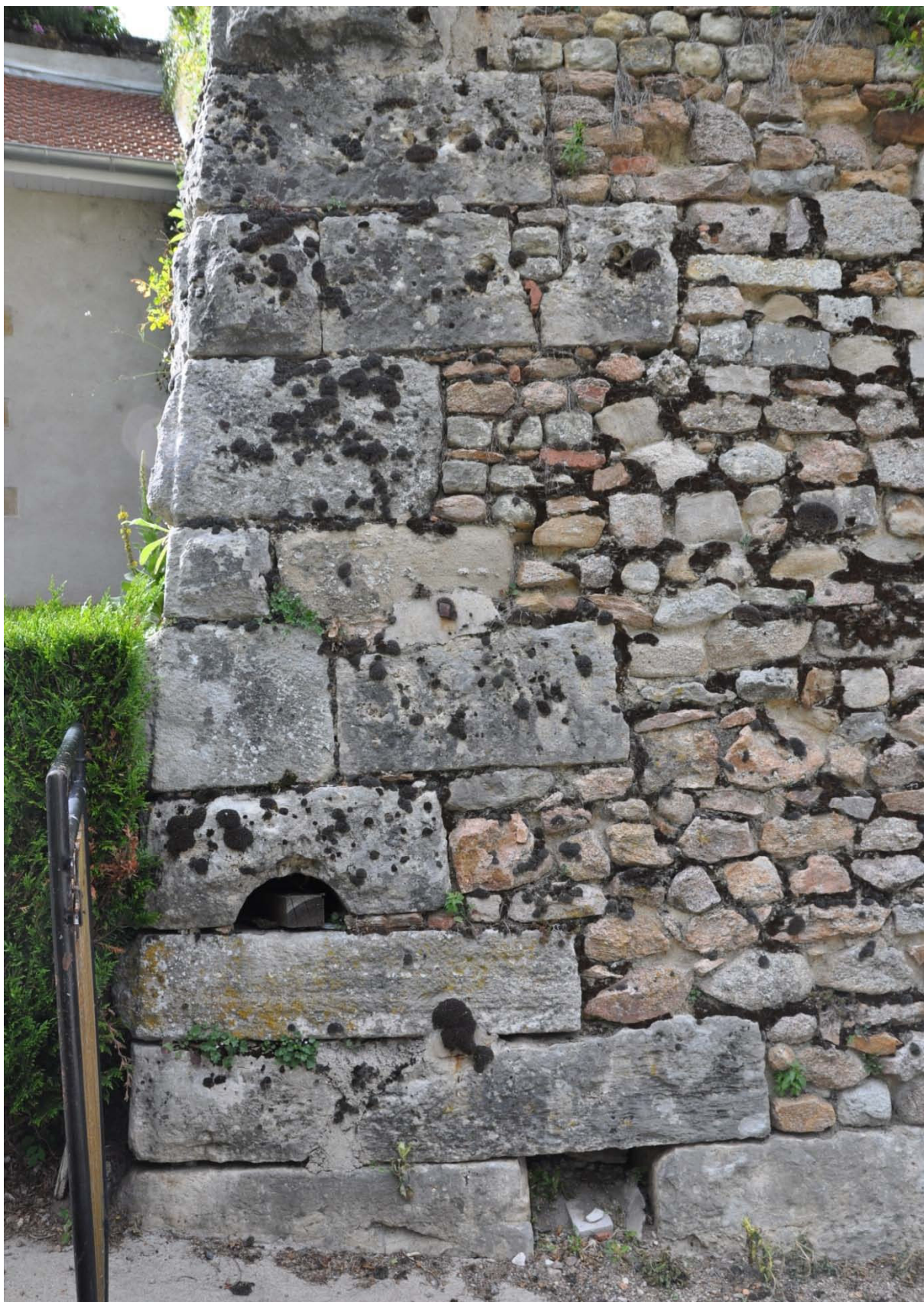
Angle sud-ouest du bastion moderne de la Jambe-de-bois, très vraisemblablement constitué à partir de blocs faisant originellement partie de la porte romaine.
