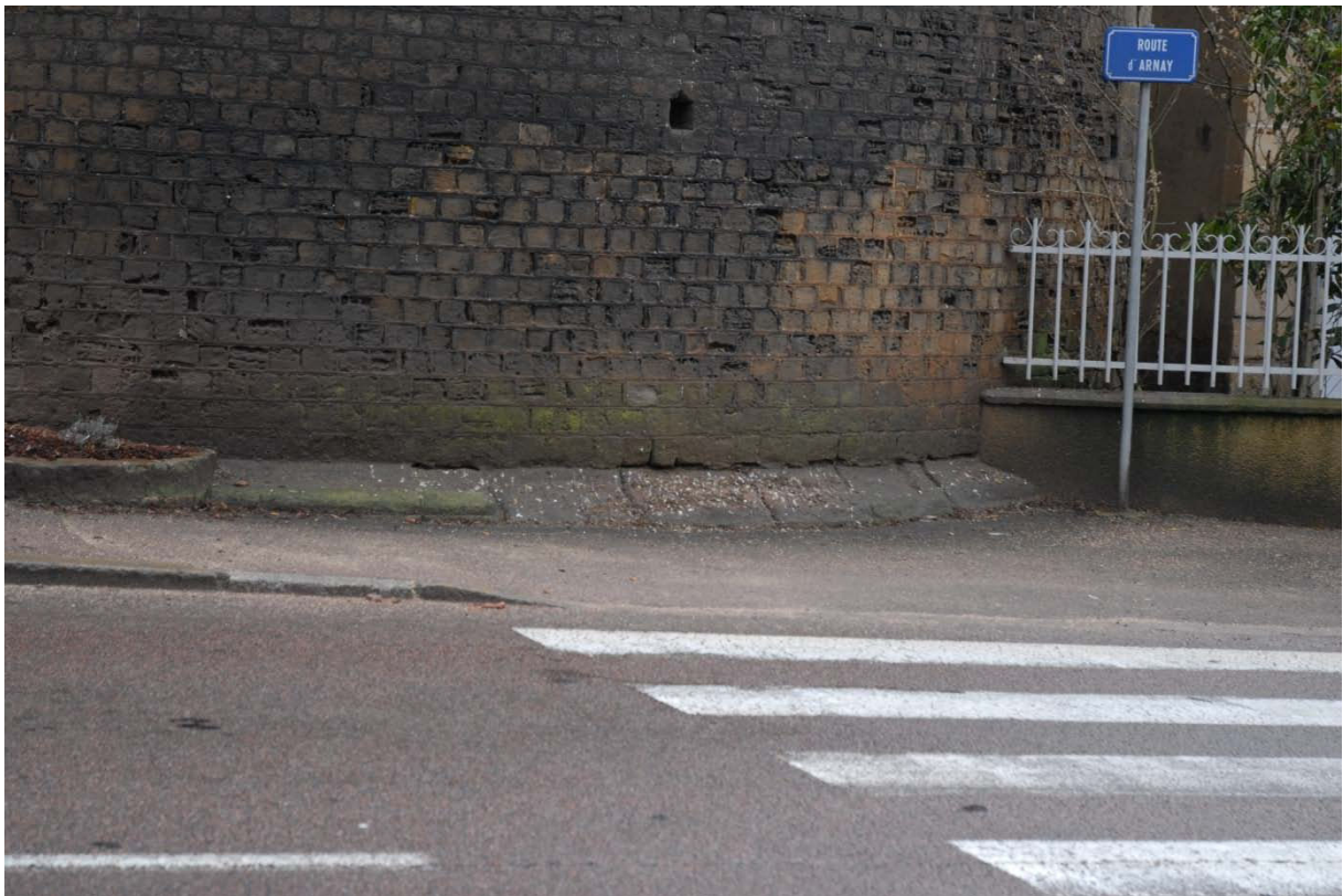
La tour de flanquement nord de la porte, vue depuis le nord-est. Rectangulaire côté ville mais semi-circulaire côté campagne, elle relève de la catégorie des tours à talon. En bas, on voit affleurer le soubassement en grand appareil.
