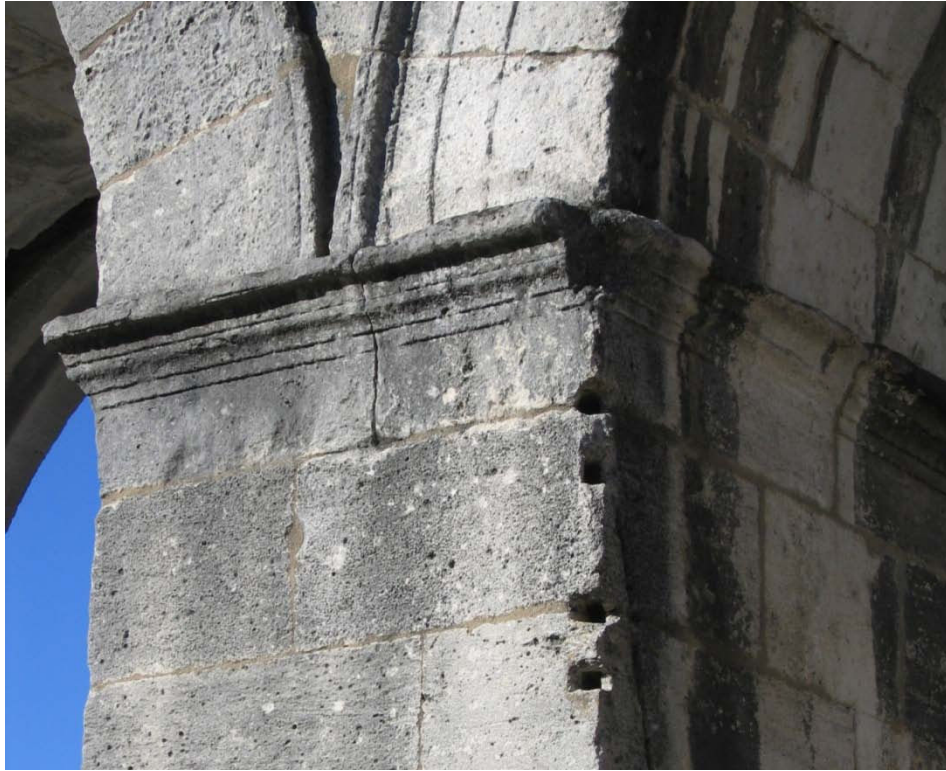
Face arrière, détail du piédroit central : quatre cavités, PAX-54 et PAX-55 en haut, PAX-56 et PAX-57 en bas, correspondant à des systèmes successifs d'éclairage au gaz.
