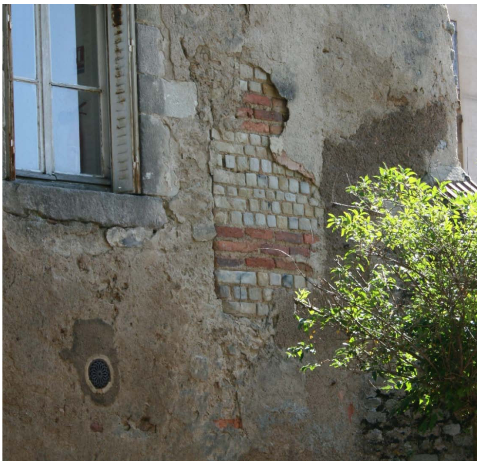
Parement extérieur ouest. Partie basse. Sous un revêtement contemporain qui se détache par plaques, apparaît un parement en opus mixtum faisant alterner assises de petit appareil quadrangulaire et assises de briques.
