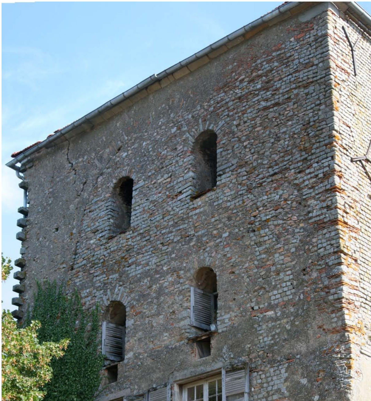
Détail de la paroi extérieure ouest : quatre baies cintrées ouvertes dans le parement. On distingue en partie haute un arc clavé (arc de décharge ou baie qui a été ultérieurement bouchée ?). Les deux angles de cette paroi disposent de chaînages différents.
