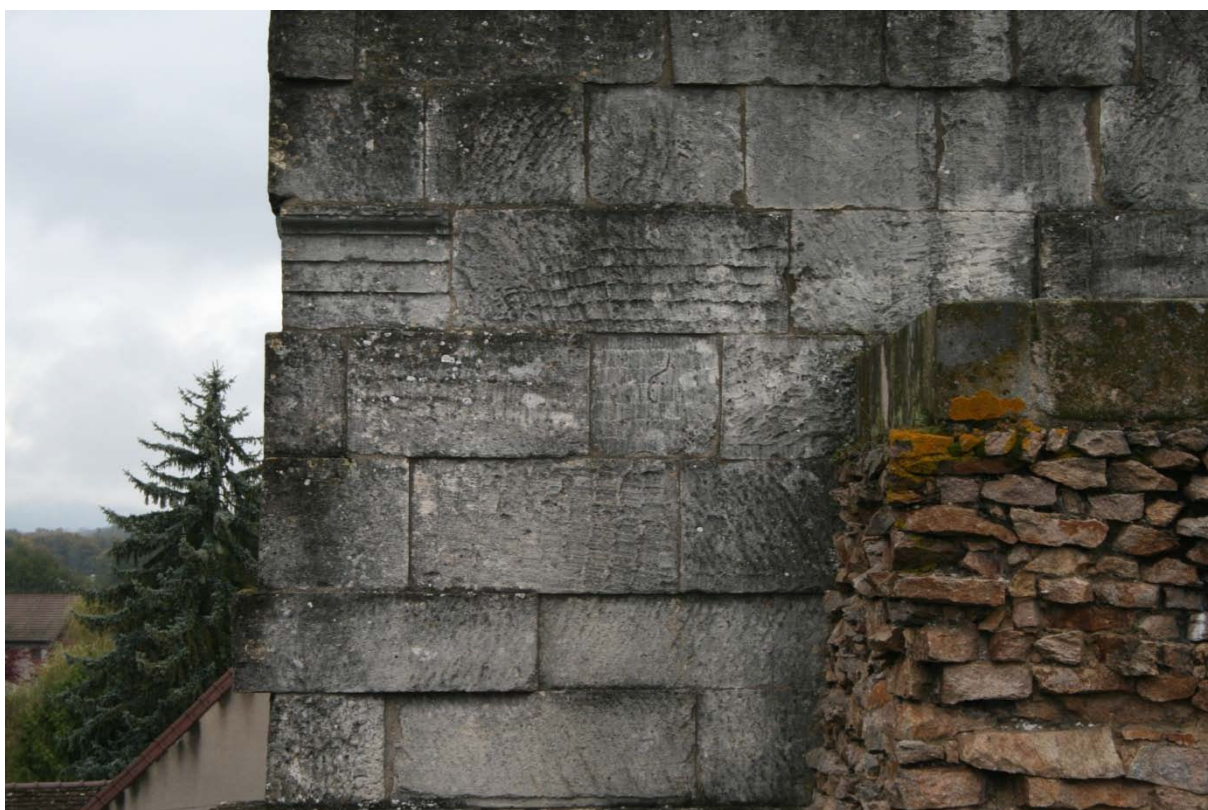
Revers de la façade : parement non ravalé, traces linéaires d'outils et bloc d'architrave réemployé au niveau de la frise.
