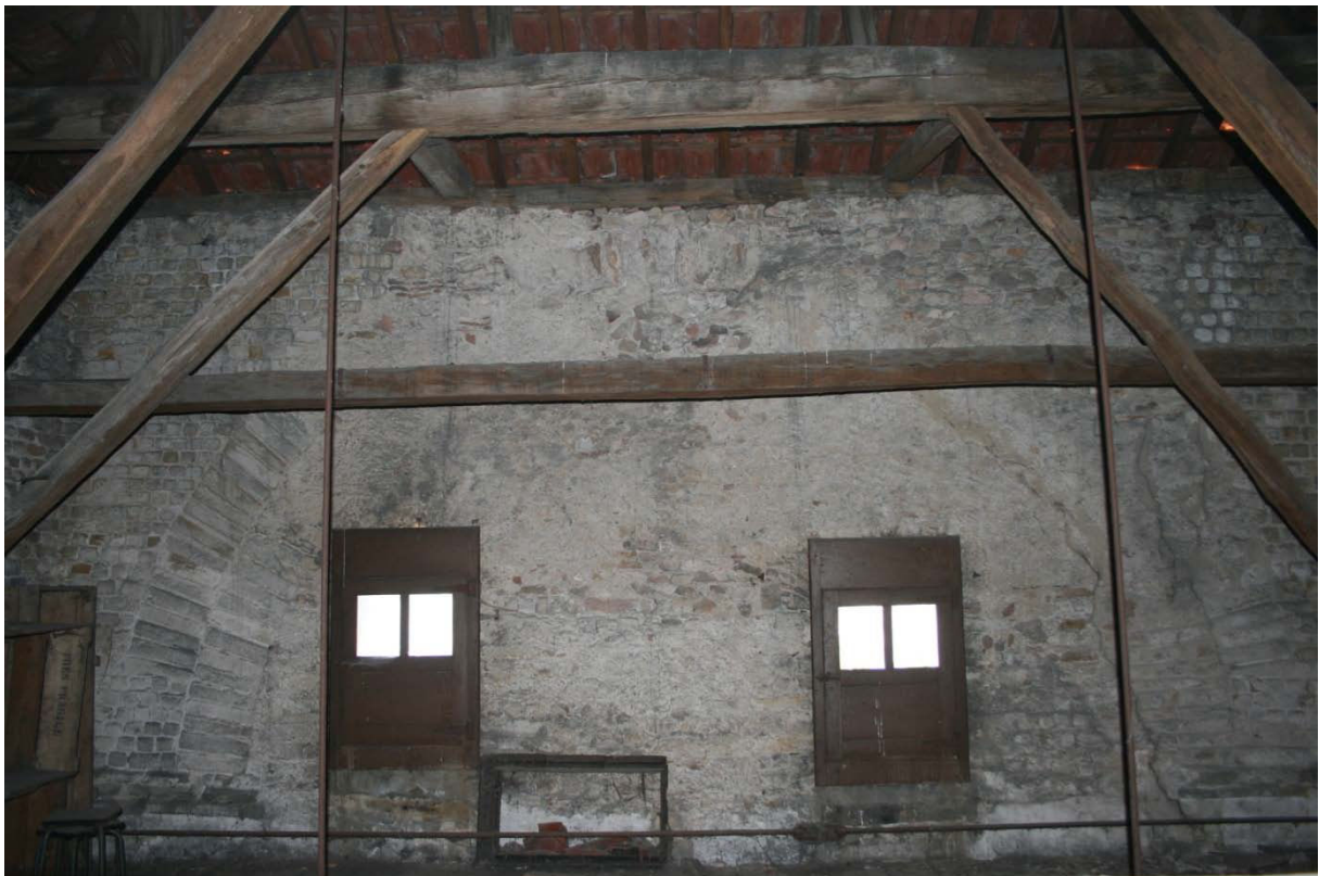
Parement intérieur ouest. Deux fenêtres sont percées dans l'arc en berceau
