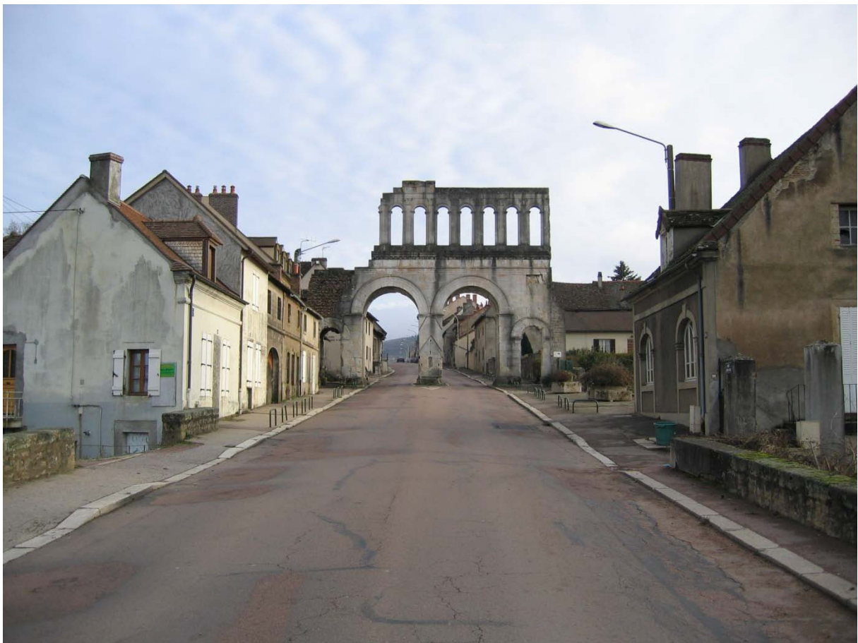
Vue de la porte romaine depuis le pont d'Arroux : perspective d'une entrée de ville.
