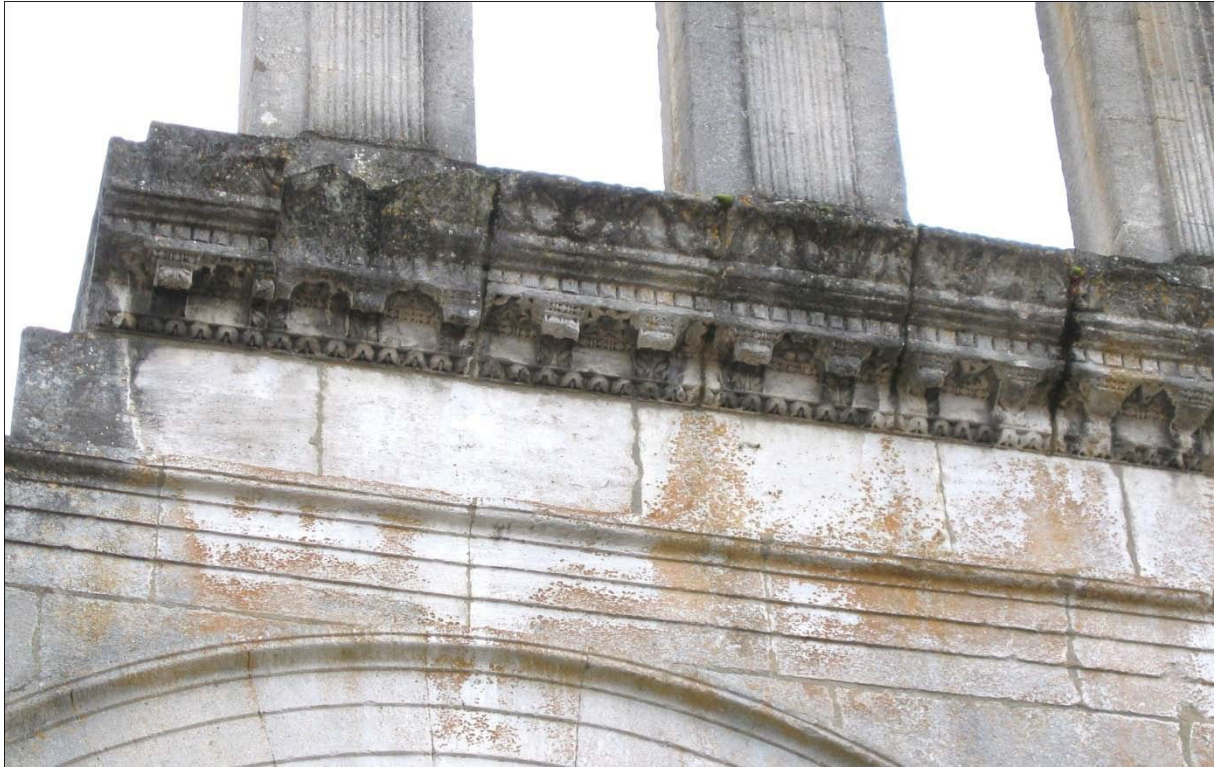
Façade de la porte : la corniche intermédiaire (PAX-25). Sur le cliché inférieur, le modillon le plus occidental présente un profil distinct (profil avant ravalement).
