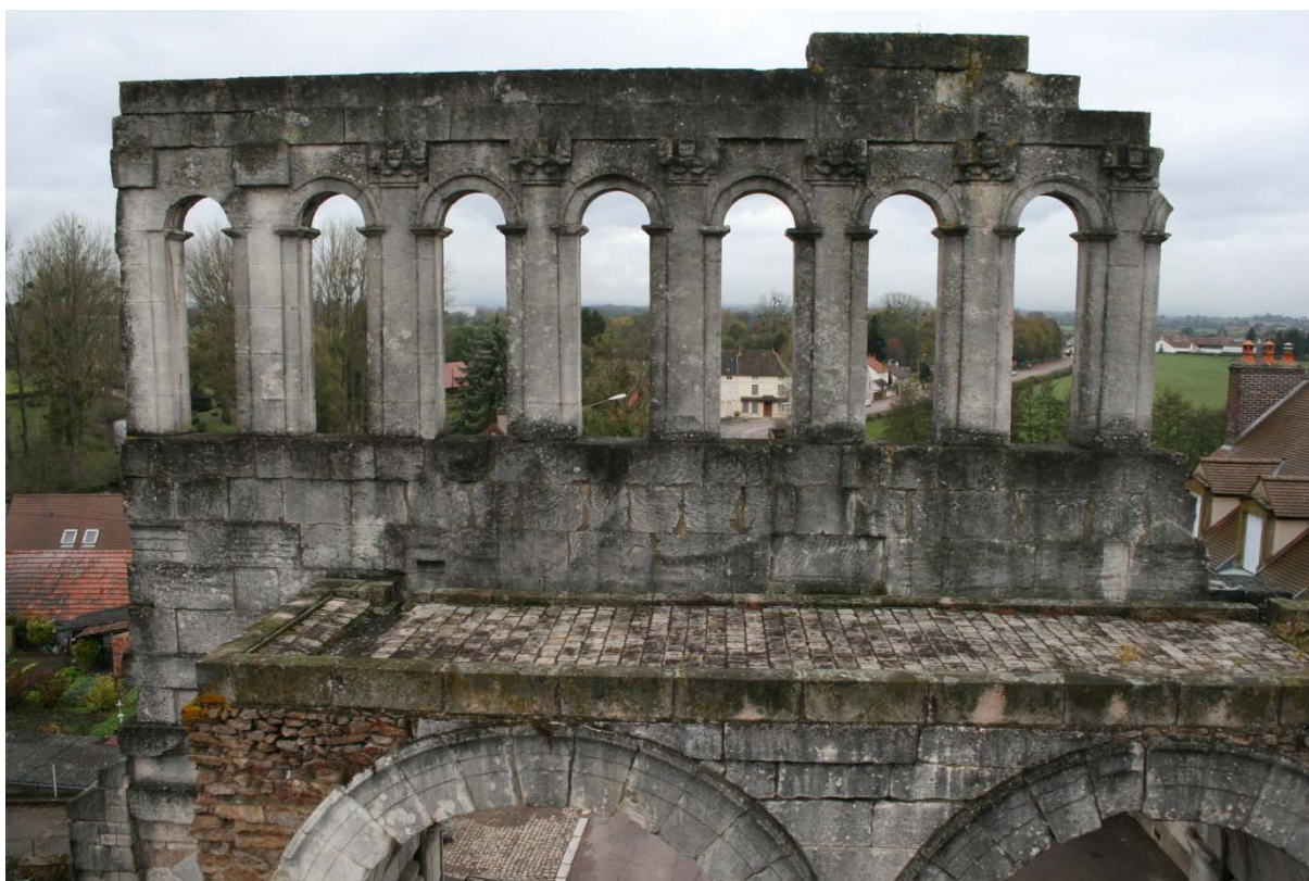
La porte d'Arroux vue depuis l'intérieur de la ville. Seules trois des quatre baies sont conservées, recouvertes par une plateforme destinée à l'évacuation des eaux pluviales (installée en 1902-1903).
