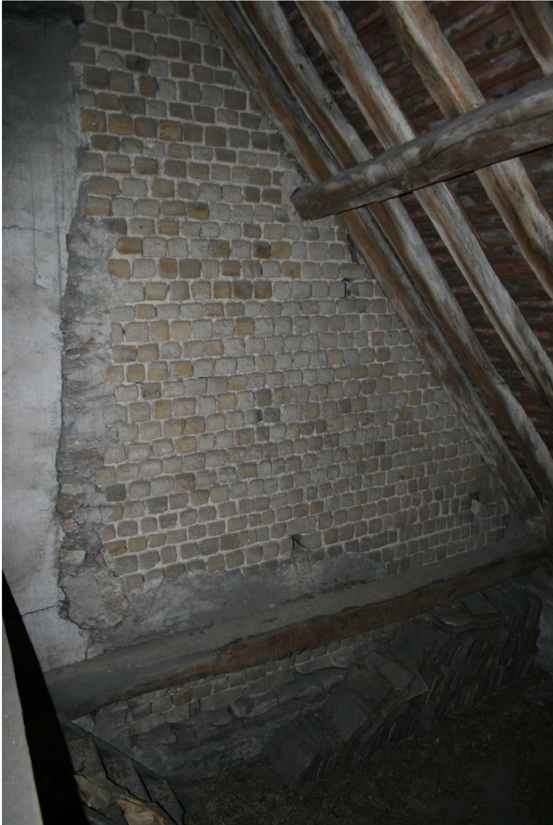
Parement extérieur nord (dans les combles de l'édifice moderne). En partie basse, le pseudo-entablement.
