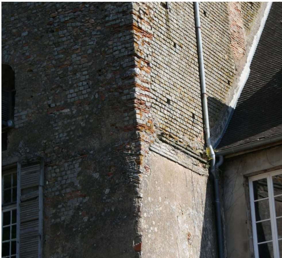
Paroi extérieure sud : pseudo-entablement intermédiaire. Enduit contemporain, en partie basse ; parement en petit appareil quadrangulaire, en partie haute (restauration contemporaine ?) ; chaînage d'angle avec assises de briques, à gauche.
