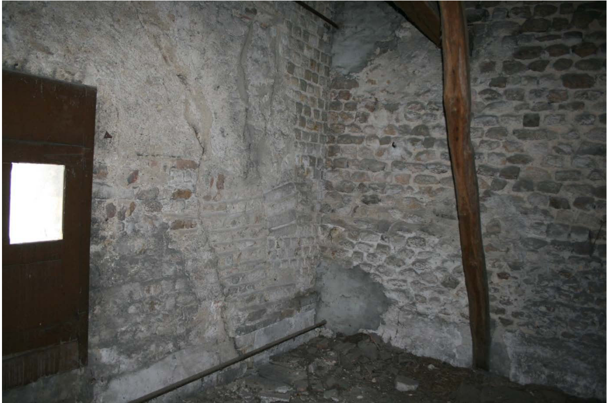
Parement intérieur ouest. Détail de l'arc clavé (départ de l'arc côté nord)
