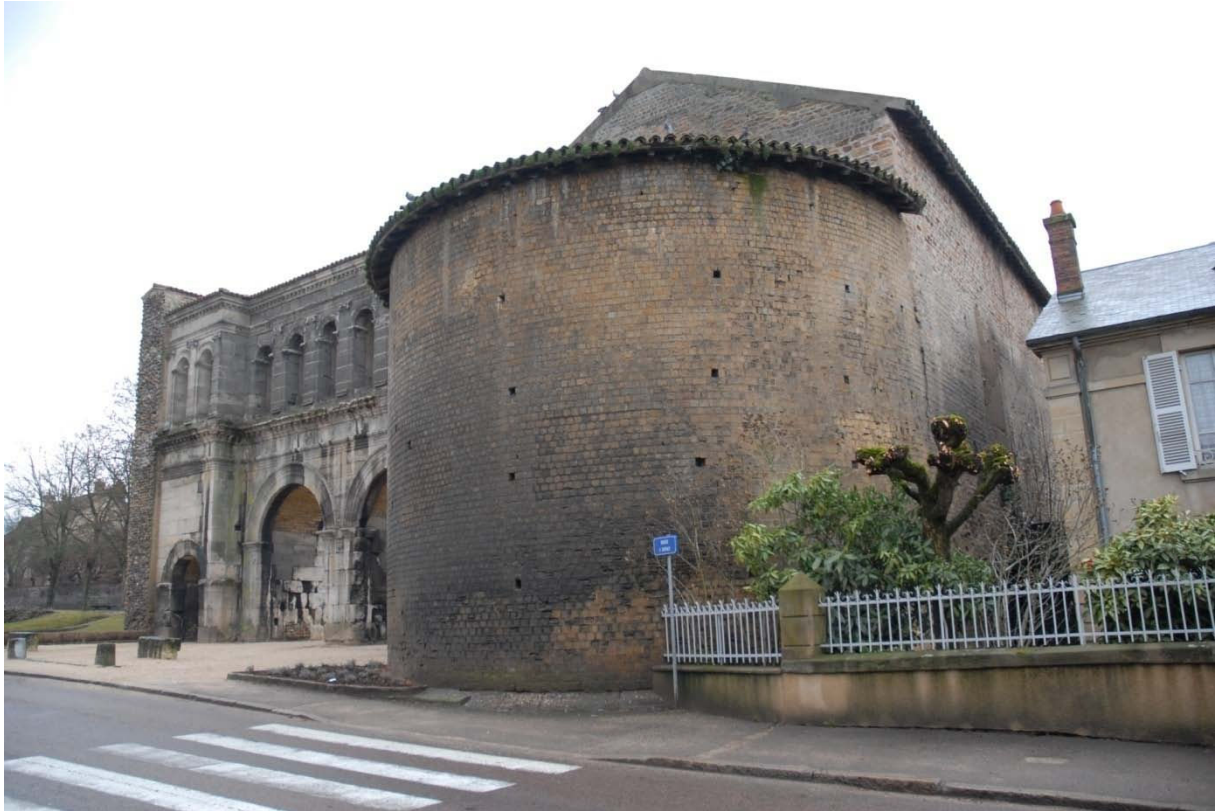
La tour de flanquement nord de la porte, vue depuis le nord-est. Rectangulaire côté ville mais semi-circulaire côté campagne, elle relève de la catégorie des tours à talon. En bas, on voit affleurer le soubassement en grand appareil.
