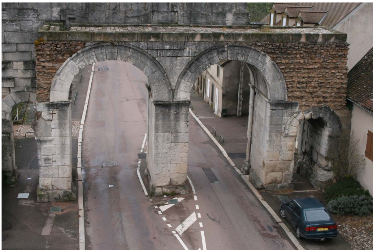
La porte d'Arroux vue depuis l'intérieur de la ville. Seules trois des quatre baies sont conservées, recouvertes par une plateforme destinée à l'évacuation des eaux pluviales (installée en 1902-1903).
