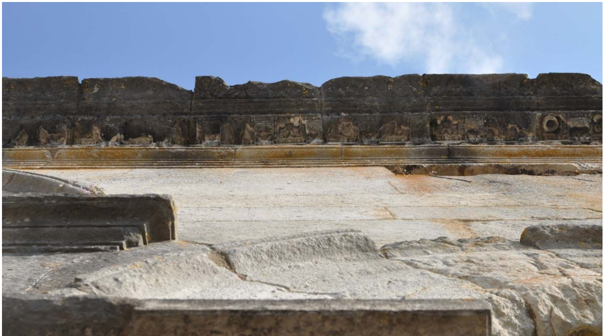
Détail de la façade : au premier plan, l'archivolte de l'arc latéral occidental, puis à gauche l'imposte droite de la grande baie occidentale, à droite le bloc à la face de parement éclatée. Enfin, on aperçoit l'architrave et la corniche saillante avec les motifs de fleurons qui ornent ses caissons.
