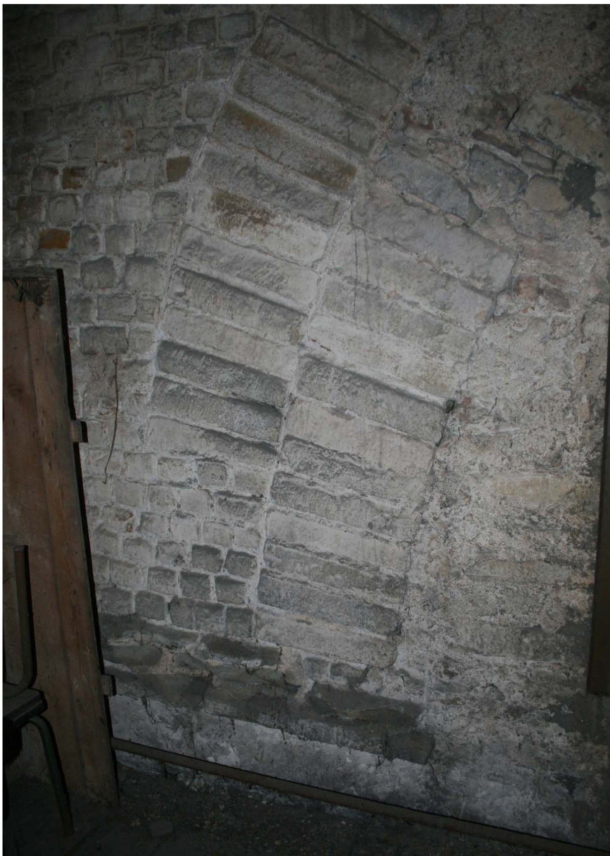
Parement intérieur ouest. Détail de l'arc clavé (départ de l'arc côté sud), deux rouleaux de claveaux, plan de naissance marqué par des assises de longs moellons allongés.
