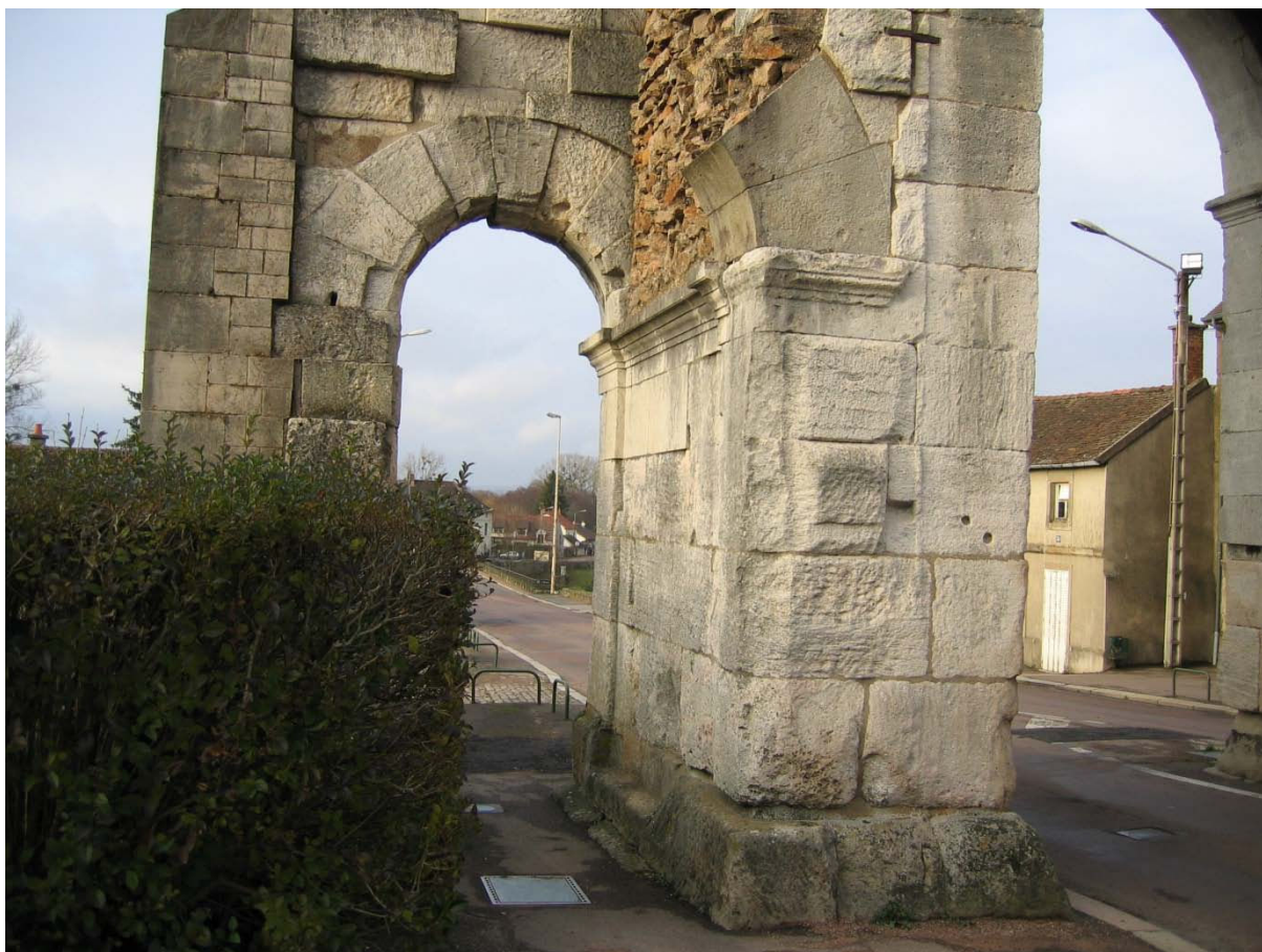
Baie latérale occidentale : une conservation partielle.
