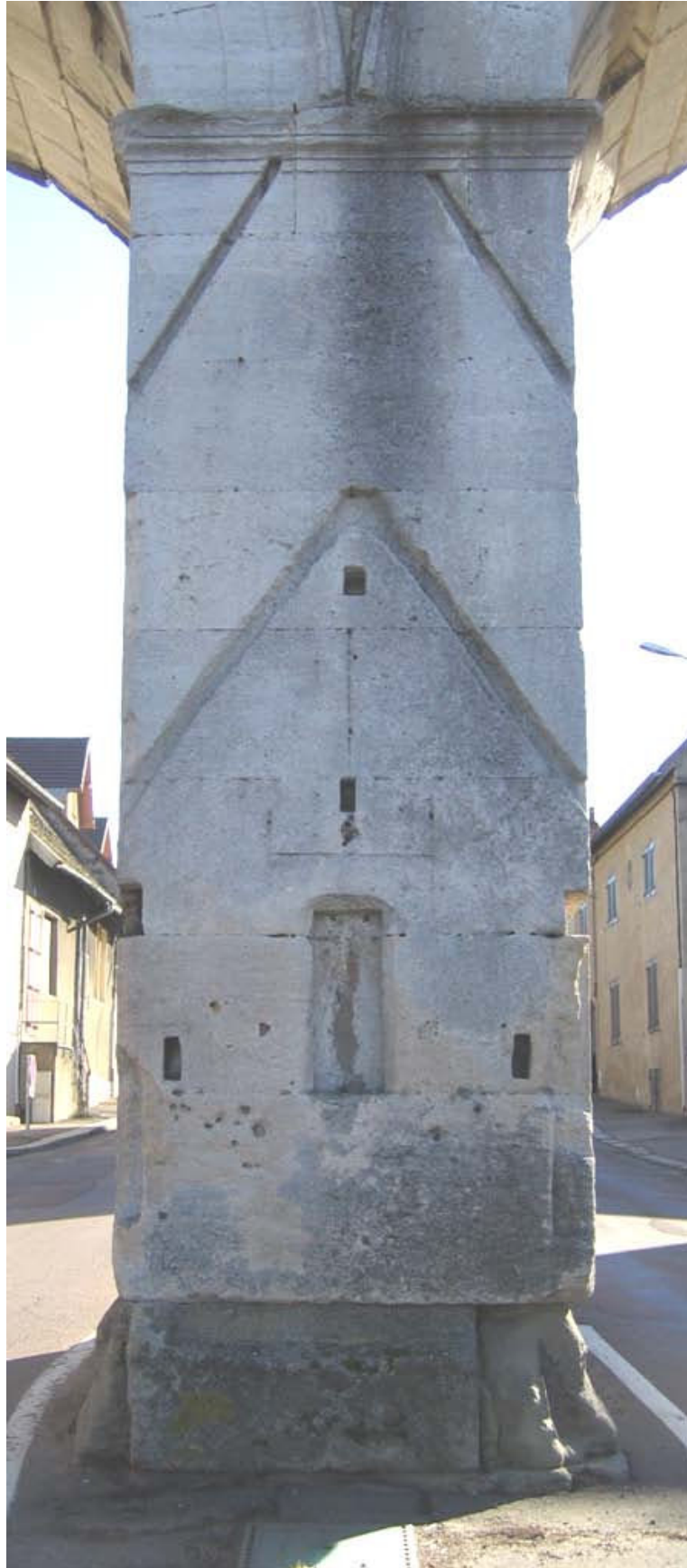
Détail de la façade : le piédroit central (PAX-11).
