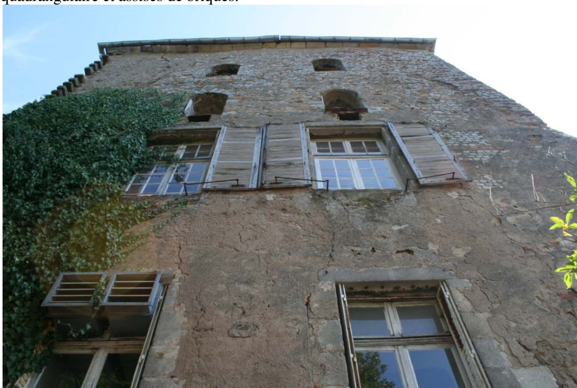
Parement extérieur ouest. Partie basse. Sous un revêtement contemporain qui se détache par plaques, apparaît un parement en opus mixtum faisant alterner assises de petit appareil quadrangulaire et assises de briques.
