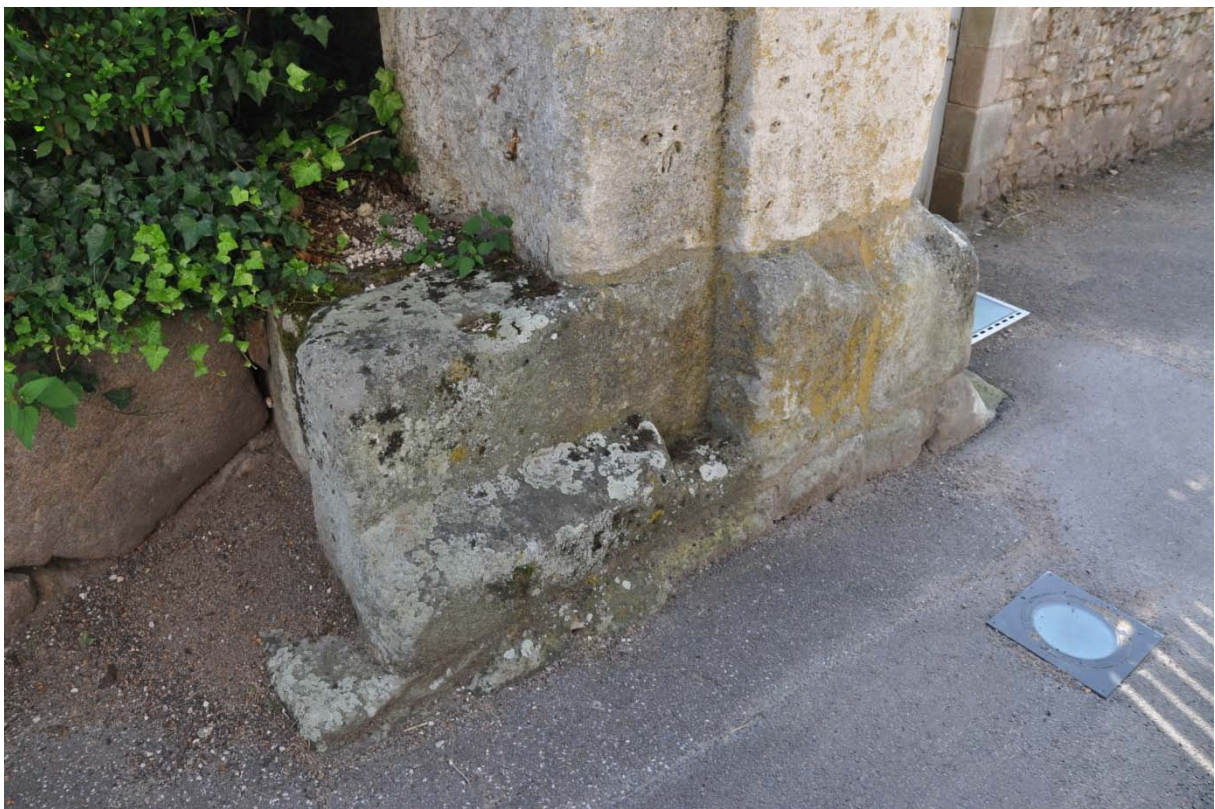
Piédroit le plus occidental de la porte, vu depuis l'intérieur de la baie occidentale. Traces liées au vantail de bois.
