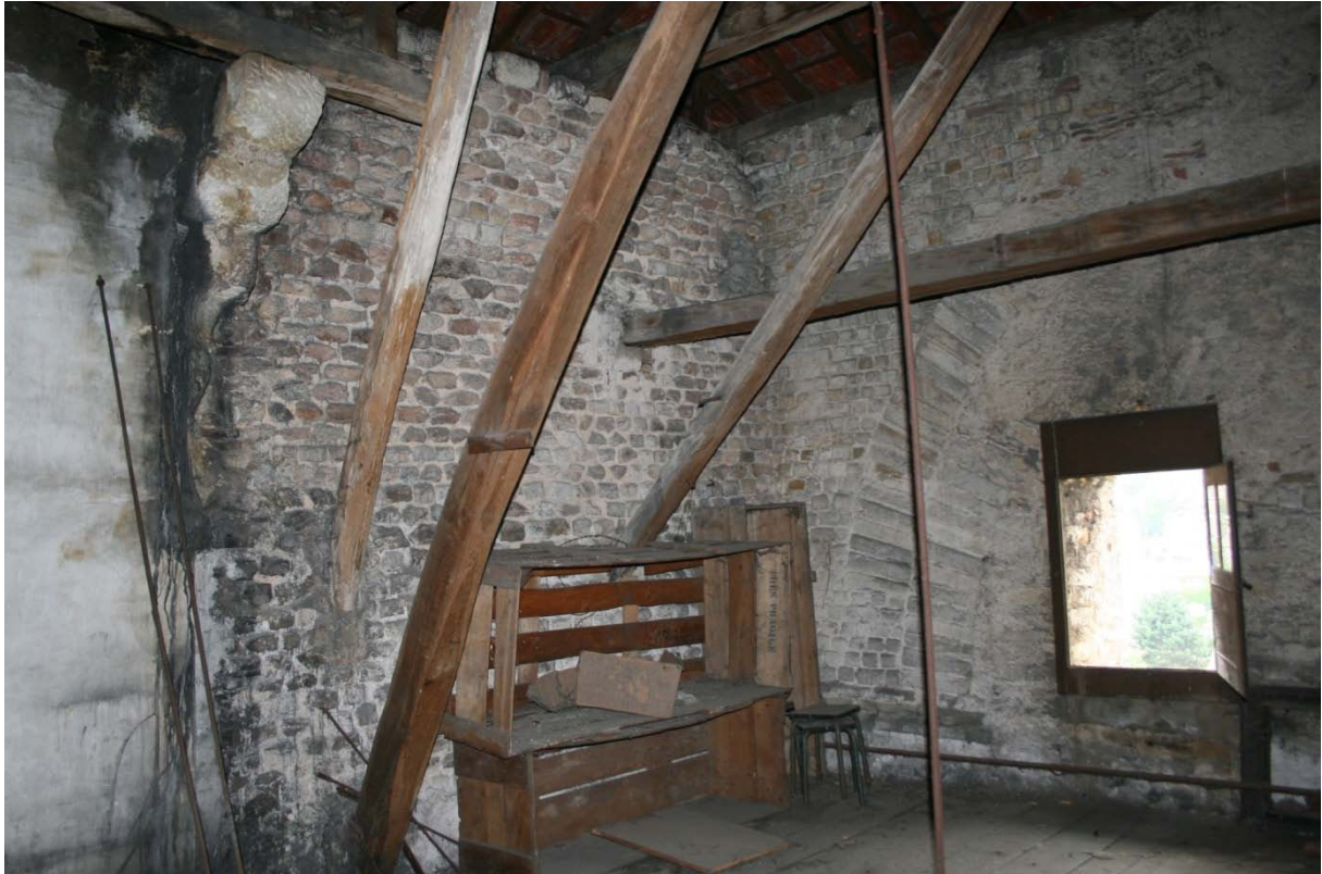
Parois intérieures sud et ouest, visibles depuis les combles à l'intérieur de la tour.
