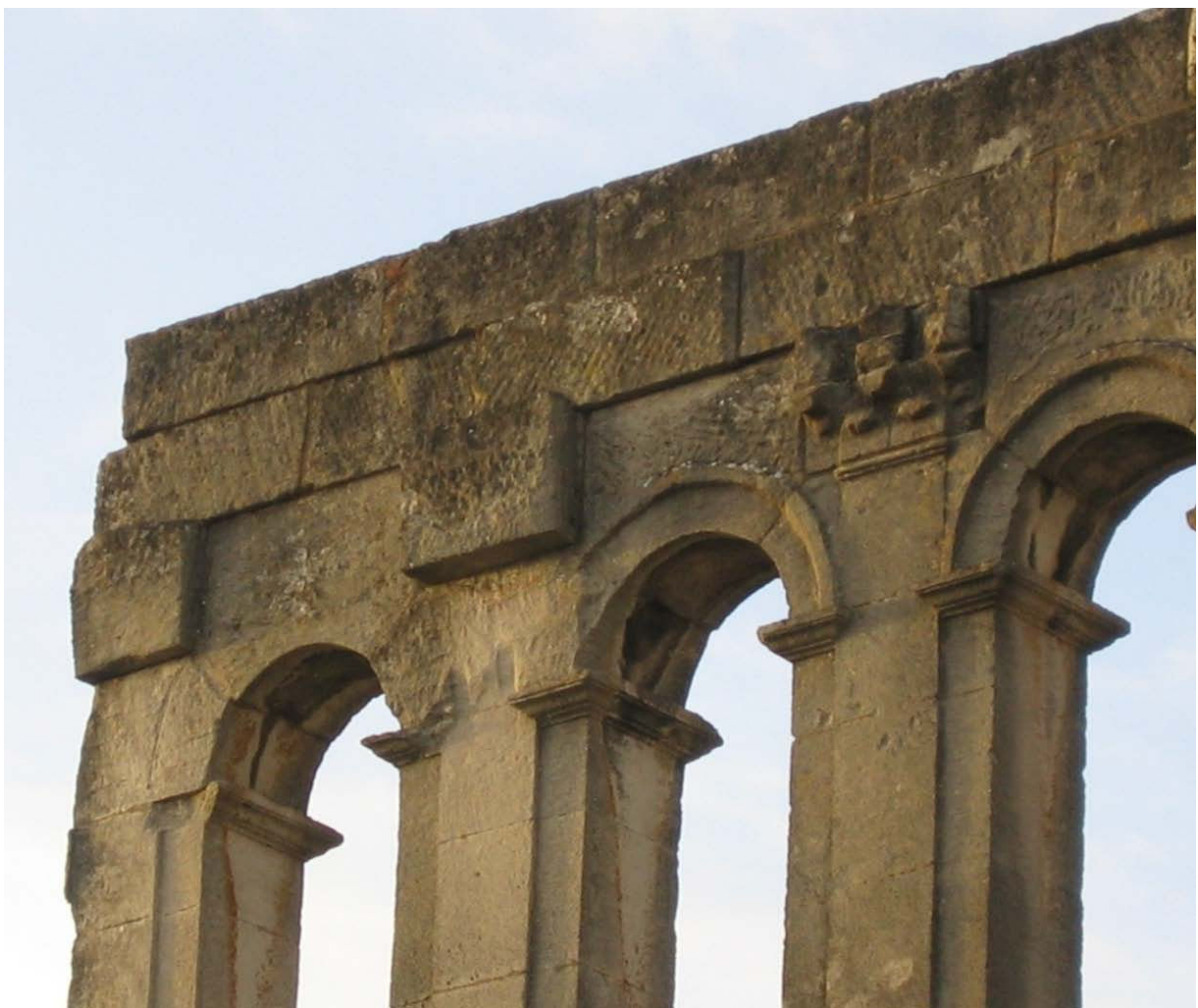
Revers de la façade : le pan de galerie supérieure conservé. Sur les huit parpaings servant de chapiteaux de pilastre, six ont été épannelés et deux ont été laissés bruts de taille (PAX-34).
