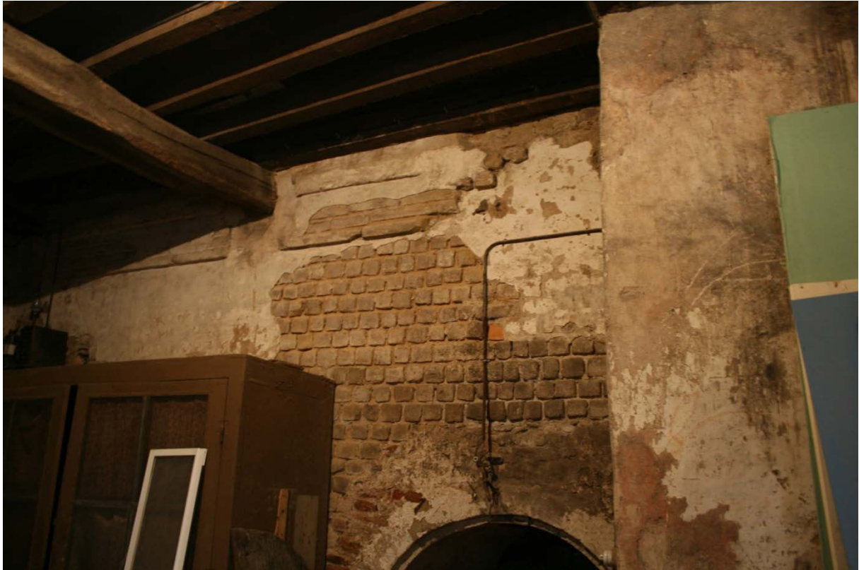
Paroi extérieure est. Pseudo-entablement visible dans un entre-sol.
