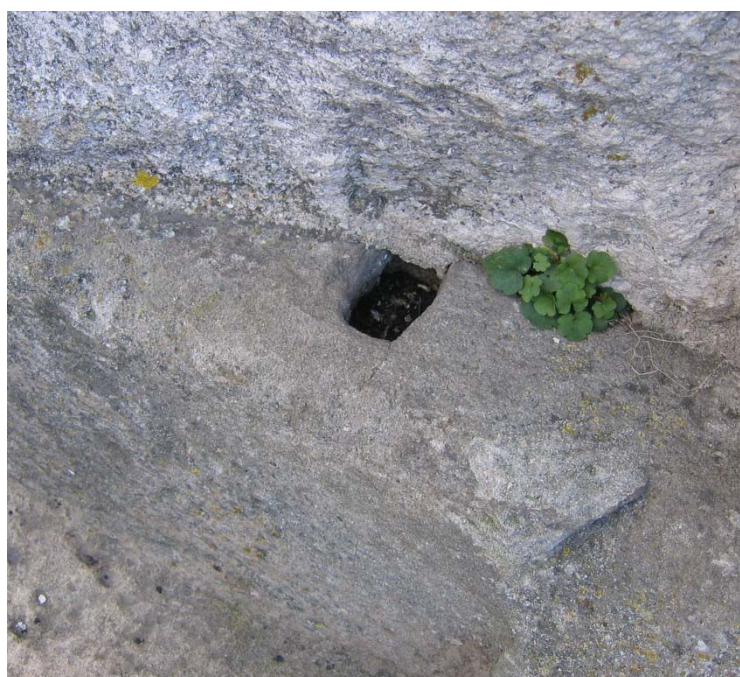
Piédroit situé entre la baie centrale occidentale et la baie latérale voisine, vu deus l'intérieur de la baie latérale disparue. Traces liées au vantail de bois et détail du probable trou de louve.
