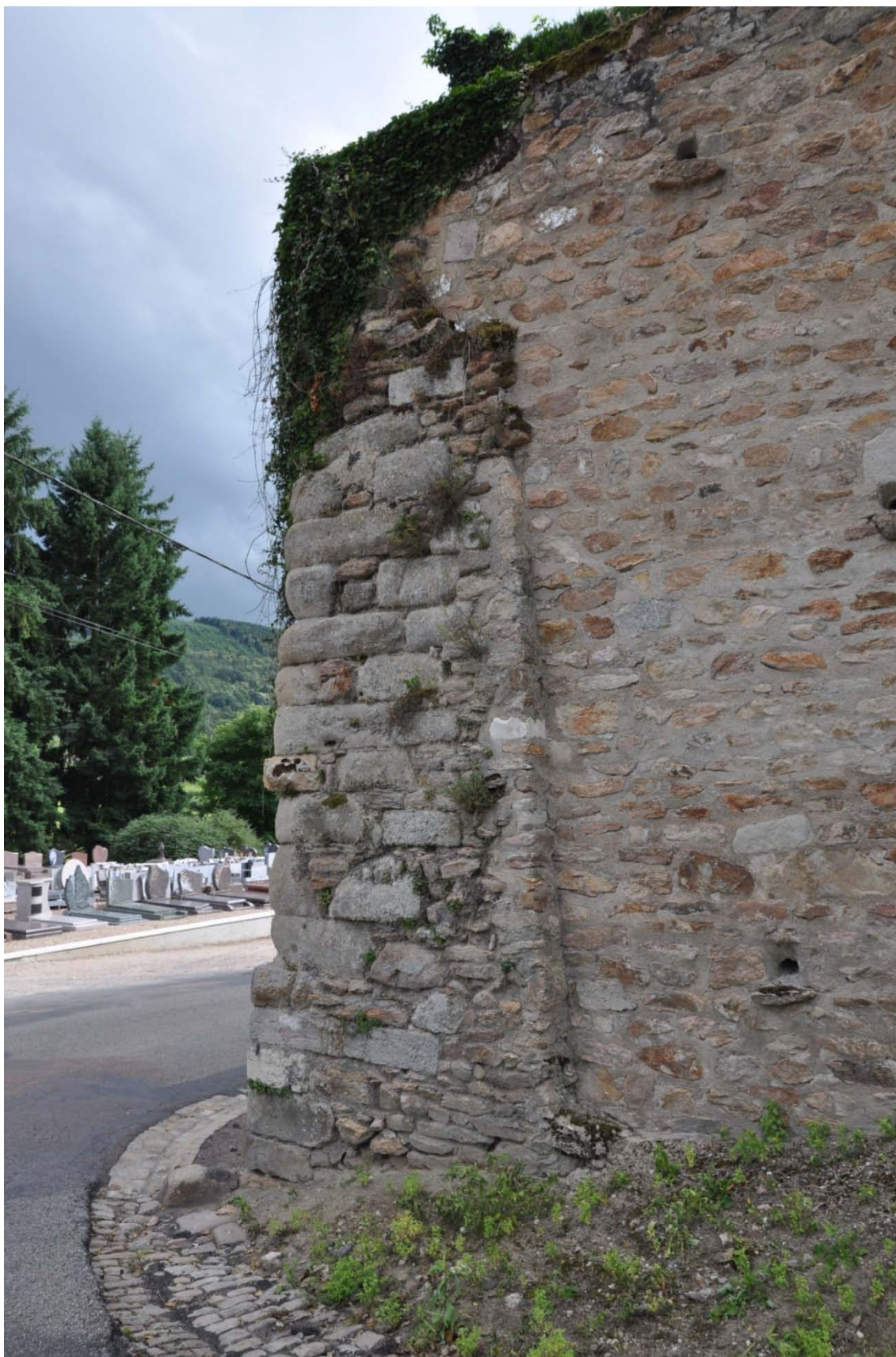
Angle sud-est du bastion moderne de la Jambe-de-bois, très vraisemblablement constitué à partir de blocs faisant originellement partie de la porte romaine.
