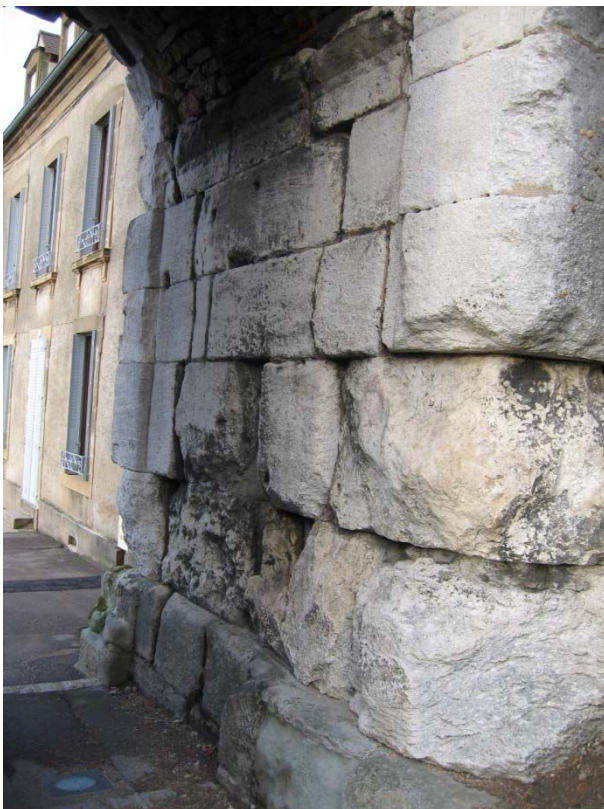
Baie latérale orientale : paroi orientale (la seule photographiable)
