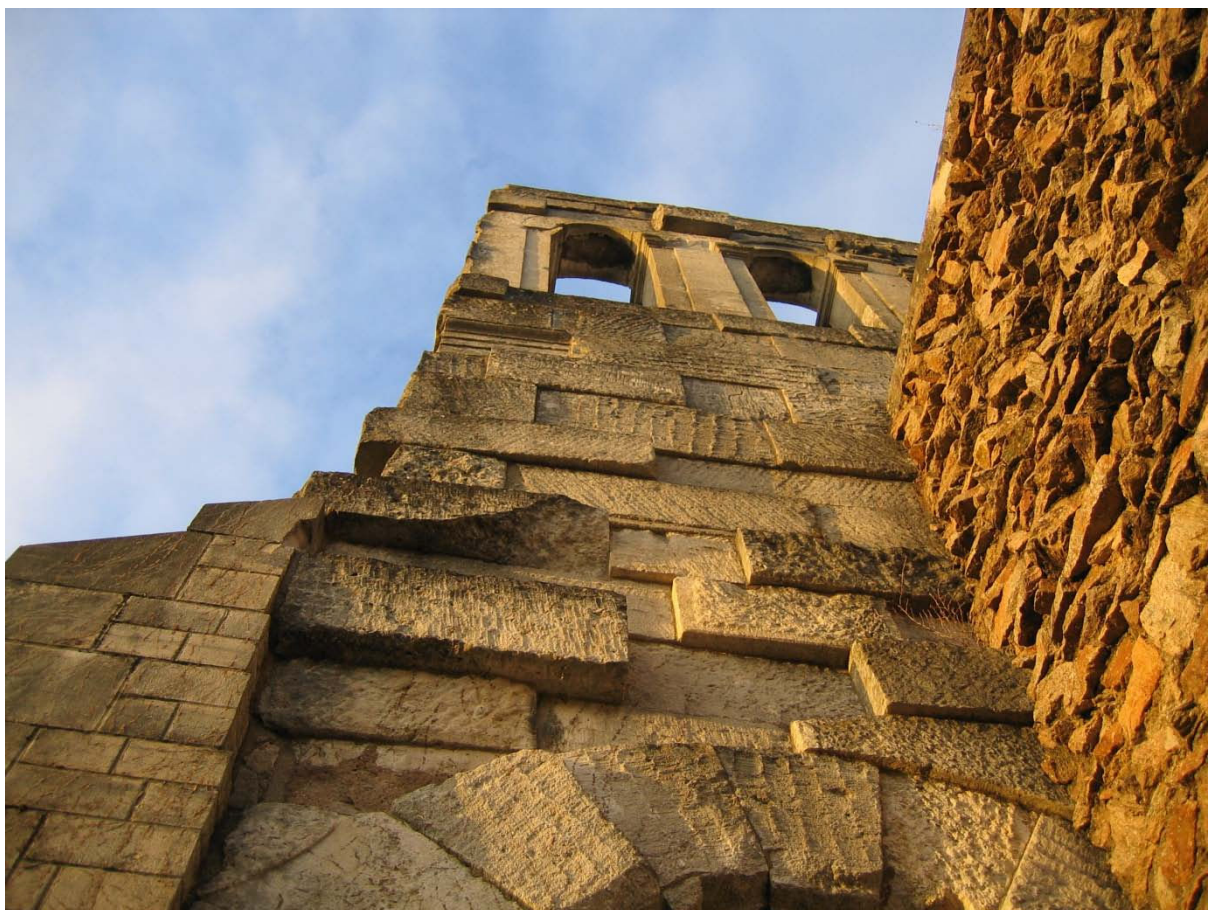
Revers de la façade : parement non ravalé, traces linéaires d'outils et bloc d'architrave réemployé au niveau de la frise.
