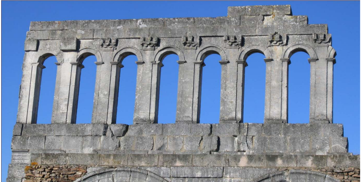
Revers de la façade : le pan de galerie supérieure conservé. Sur les huit parpaings servant de chapiteaux de pilastre, six ont été épannelés et deux ont été laissés bruts de taille (PAX-34).
