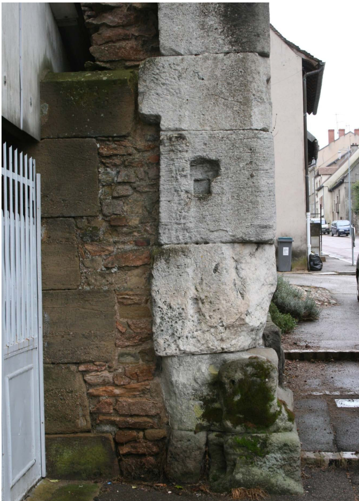
Vue de la baie latérale orientale (façade côté campagne) : les contreforts PAX-1 et PAX-2 au contact du piédroit PAX-9 et de son soubassement PAX-3. Les deux cavités quadrangulaires accolées correspondent à l'US PAX-59. On aperçoit également en haut à gauche le massif maçonné PAX-14 (restaurations de 1902-1903).
