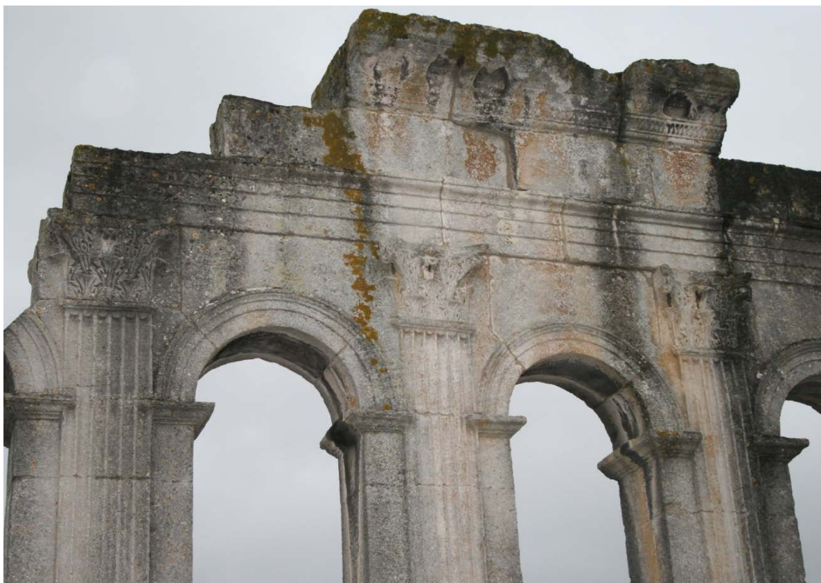
Façade de la porte d'Arroux : le pan de la galerie supérieure conservé. Détail de l'ordre architectural (PAX-26, PAX-27, PAX-28, PAX-34 et PAX-35) et des faces de joint au niveau de la cassure laissant voir les cadres d'anathyrose (PAX-25).
