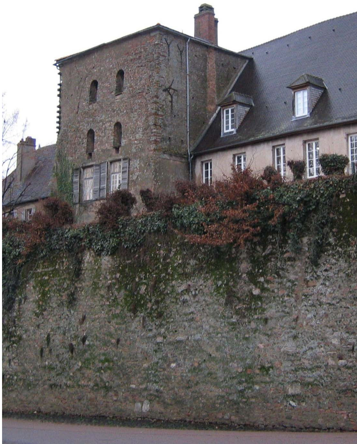
Vue de la tour Saint-Andoche depuis le boulevard des Résistants fusillés (parois ouest et sud). Au premier plan, l'enceinte d'époque moderne.
