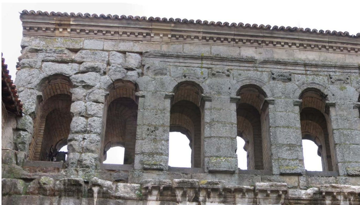
Face arrière, vue depuis l'intérieur de la ville. En bas, détail de la partie nord de la galerie supérieure : dégradation du parement (en raison d'un incendie ?).
