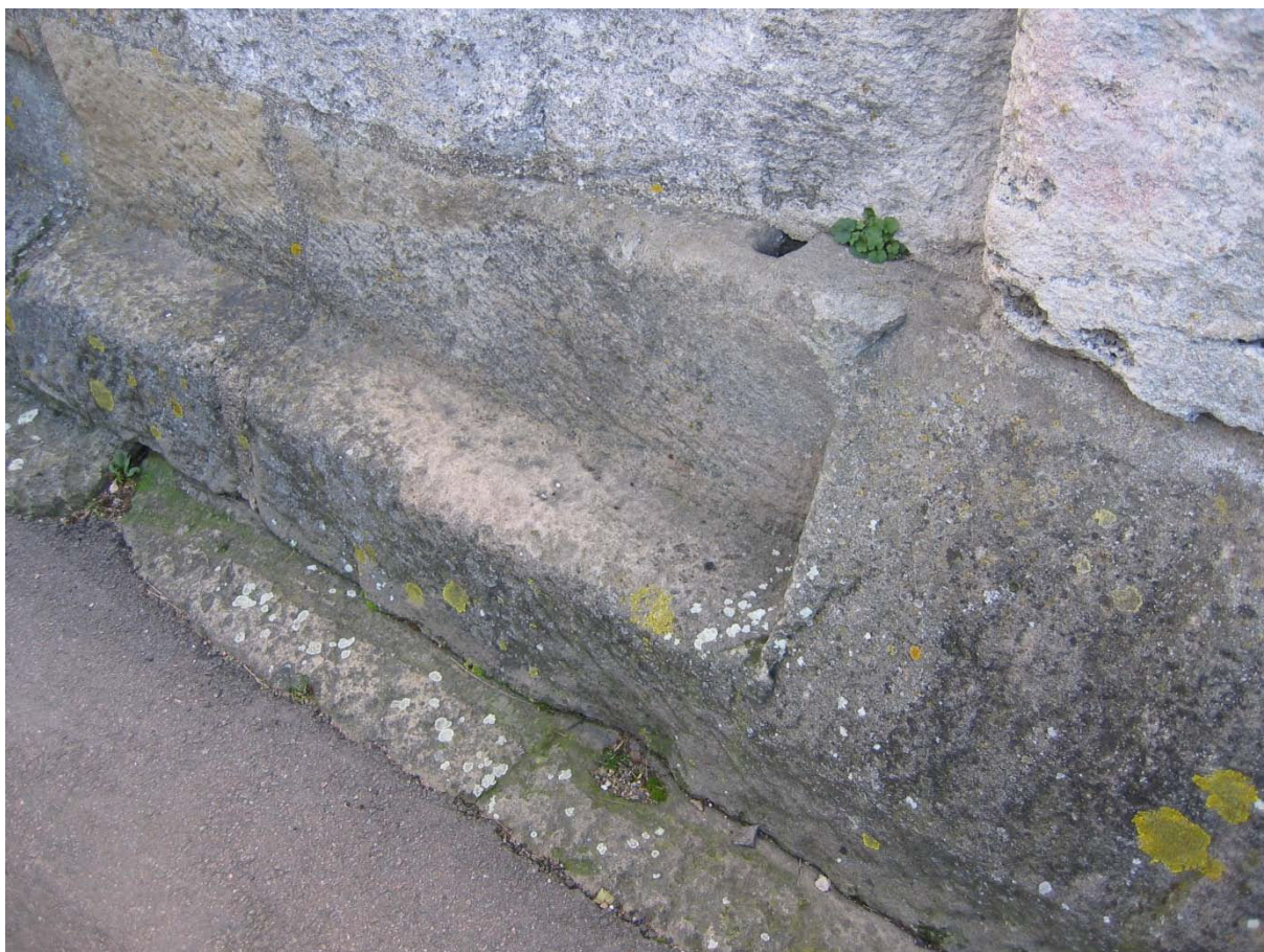
Piédroit situé entre la baie centrale occidentale et la baie latérale voisine, vu deus l'intérieur de la baie latérale disparue. Traces liées au vantail de bois et détail du probable trou de louve.
