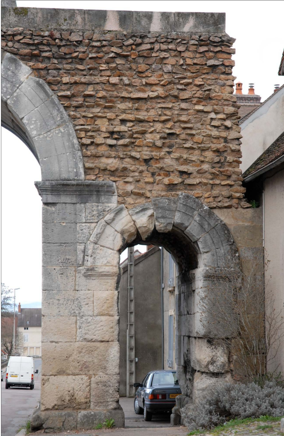
Face arrière, baie latérale occidentale : on observe sur le piédroit de gauche une zone non ravalée correspondant à l'aménagement d'un mur perpendiculaire en petit appareil.
