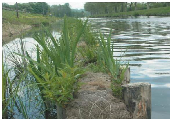
*Figure 24 : aménagements en zone humide des berges d'un canal. (Sources : VNF, 2006)*
