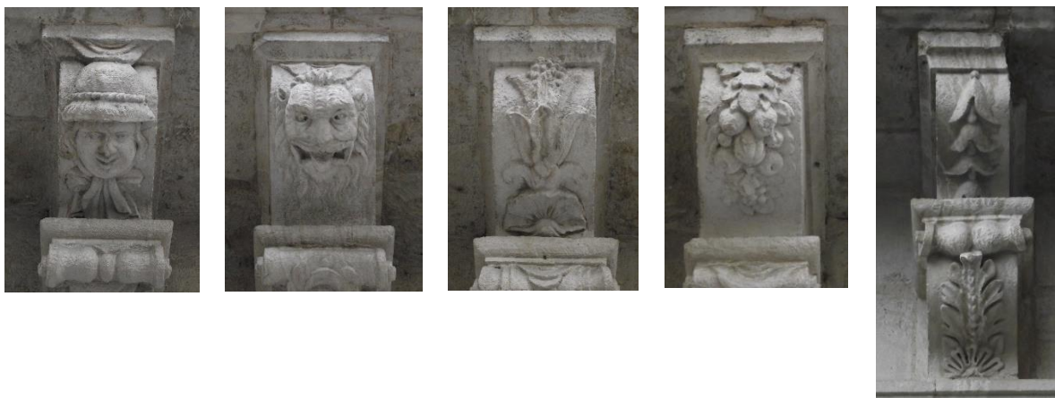
FIGURE 5 : EXEMPLES DE MOTIFS QUI DECORENT LES CONSOLES SOUTENANT LE BALCON
