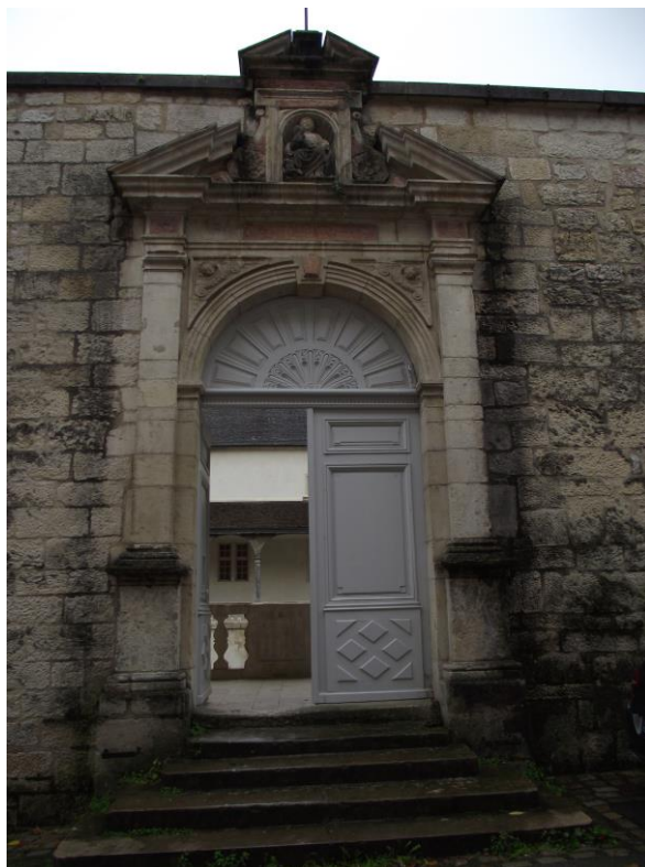
FIGURE 8 : ANCIENNE PORTE PRINCIPALE
