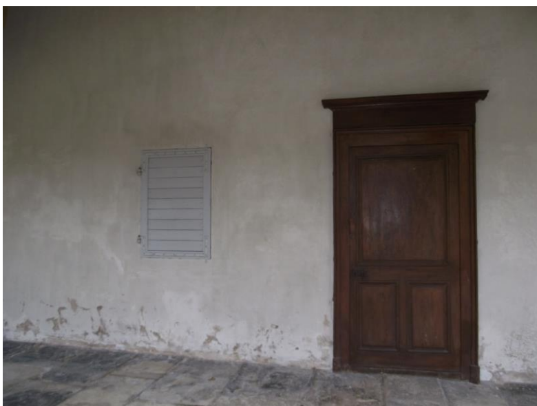
FIGURE 41 : LA PORTE DU BUREAU DE LA MAITRESSE, ET LE "PASSE-PLAT" A GAUCHE
