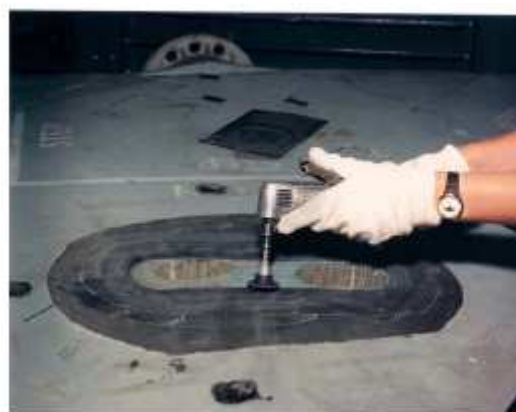
Figure 1.14. Préparation de surface pour collage des patches internes [40]
