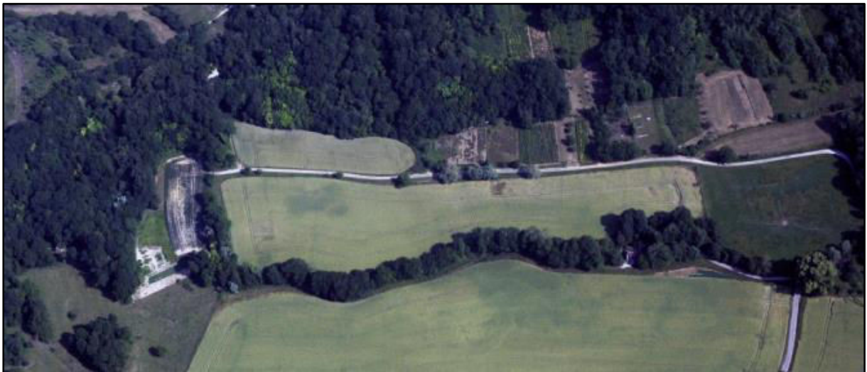
Figure 7 : Balesmes-sur-Marne, « La Marnotte » : Photographie aérienne des Sources de la Marne (cliché A. Cordier, 2010).
